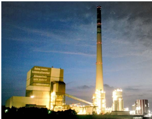
Das bestehende E.ON Kraftwerk, bei dem Ausbaupläne für einen 2. Block existieren, könnte bald Zuwachs durch das geplante Electrabel Kohlekraftwerk bekommen. © Greenpeace
